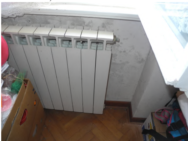
FOTO 49 – alloggio primo piano (sub. cat. 5); camera, evidenza fenomeni infiltrativi
